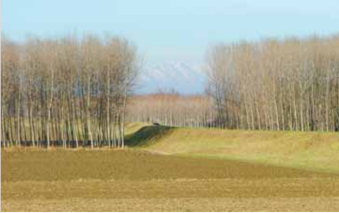
La golena del Po nei pressi di Carbonara • Holm of the Po river near Carbonara
