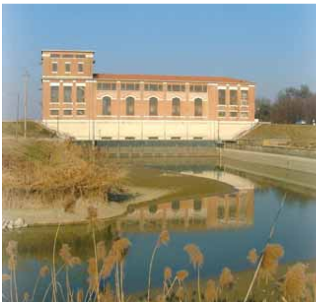
Impianto Idrovoro di Mondine - Draining pump of Mondine
